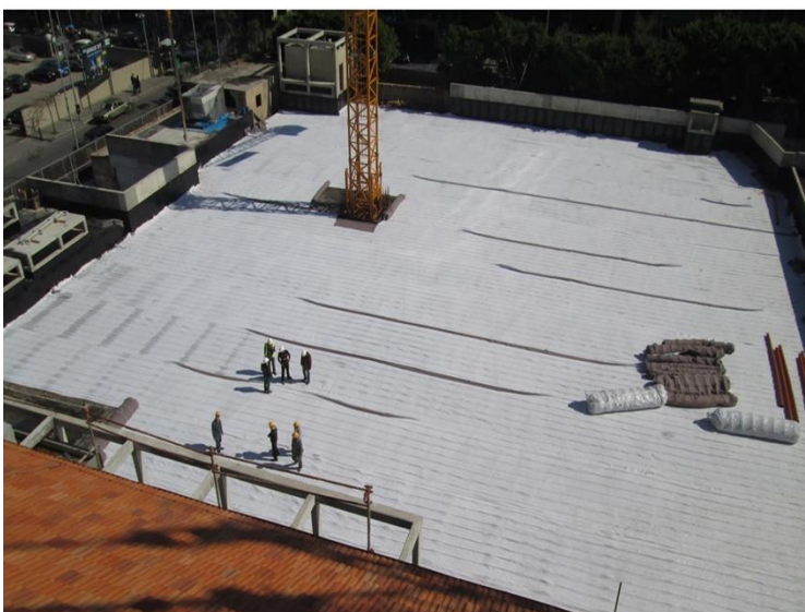
Vue globale sur le chantier.
