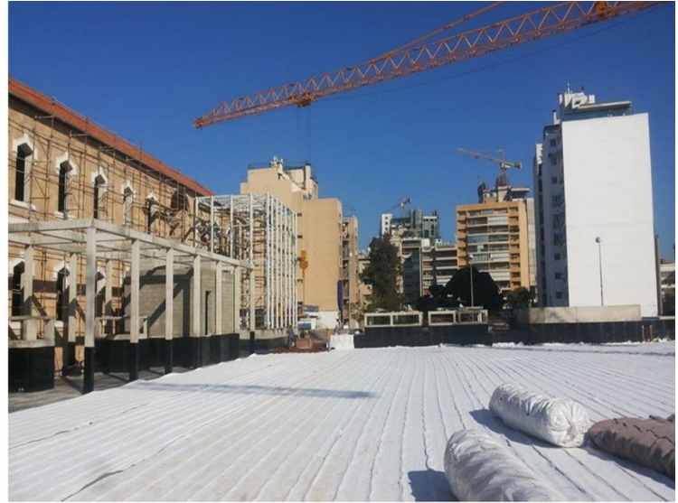
La pose presque terminée
