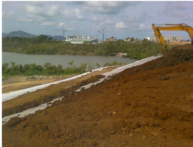
Figure 8. Mise en œuvre de la terre végétale
